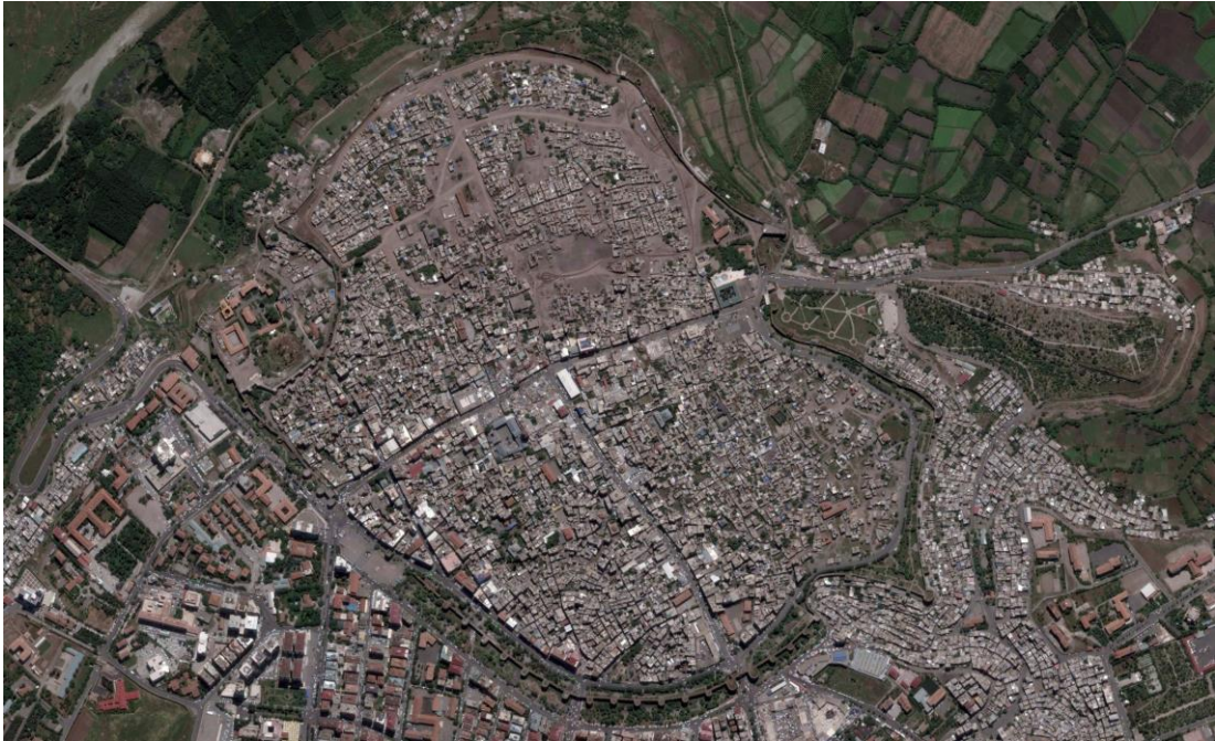
Silahlı çatışmaların sona ermesi ve Mart ayında alınan "acele kamulaştırma" kararının ardından, 10 Mayıs 2016 tarihinde çekilen uydu görüntüleri, şehrin doğu kesiminde bulunan binaların kayda değer bir bölümünün hasar gördüğünü ya da yıkıldığını gösteriyor. © Google Earth, DigitalGlobe
